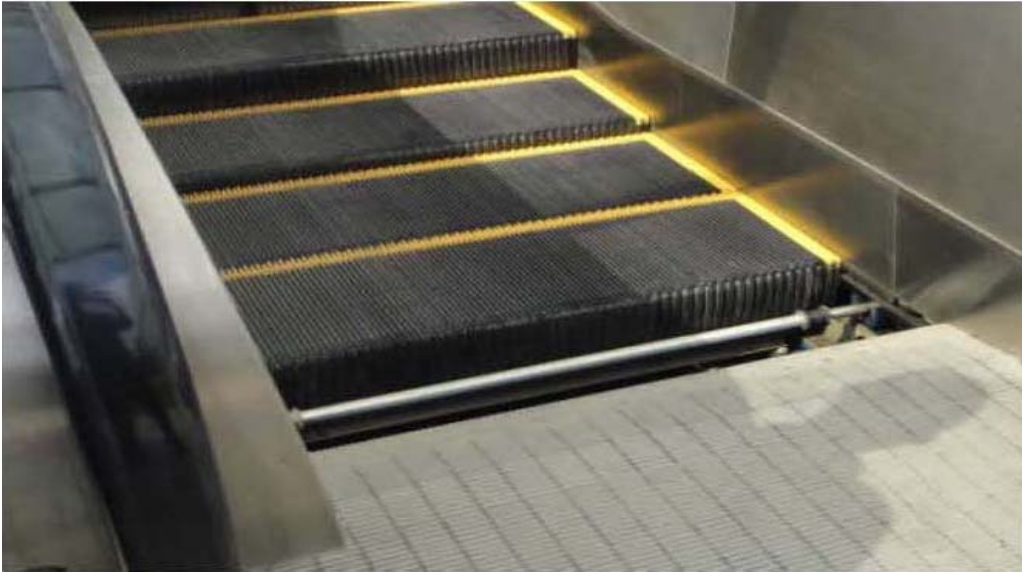
图 24、梯级或踏板的缺失保护示例
